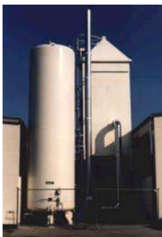
Slika 7: Naprava za čiščenje zraka z absorpcijo
