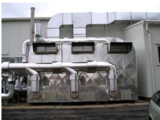
Slika 8: Naprava za čiščenje zraka z adsorpcijo
